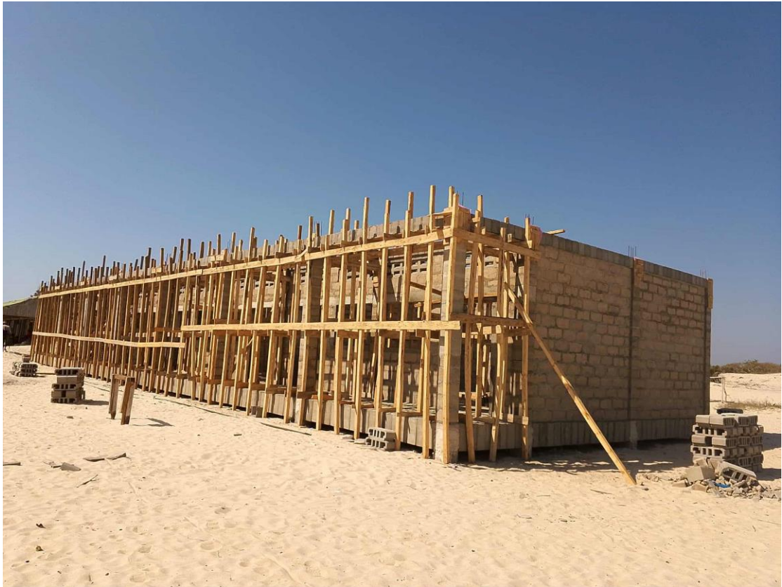
École primaire en construction à Ankev, Madagascar, 2025
