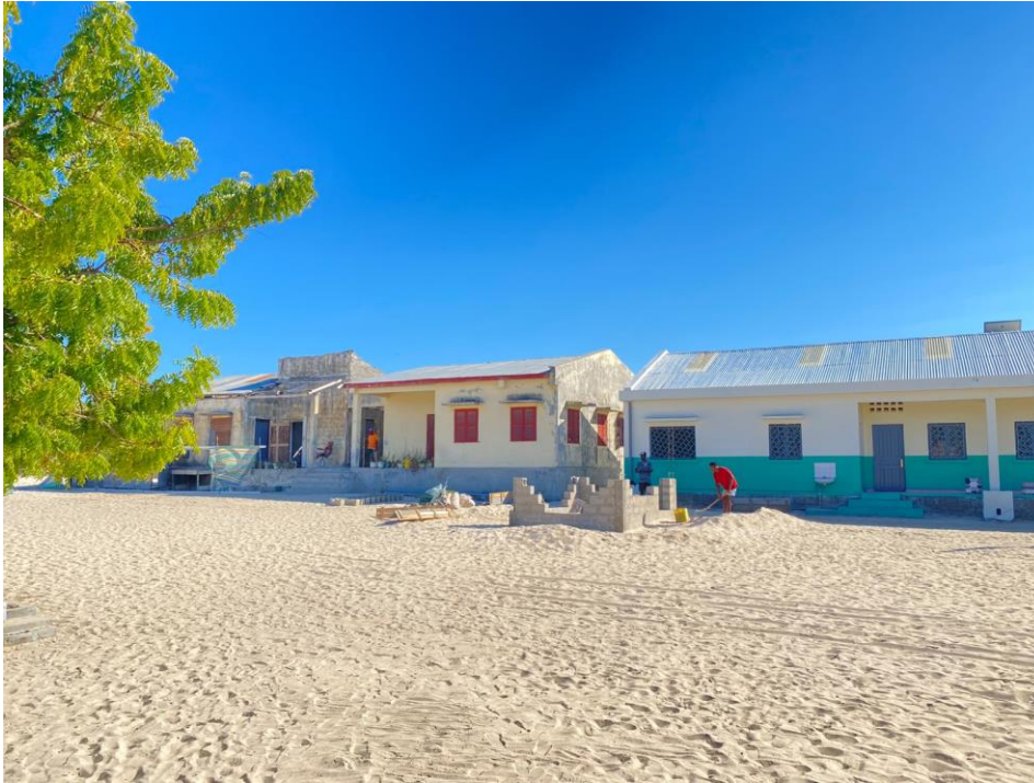
Réhabilitation du dispensaire de Belo sur Mer, 2026
