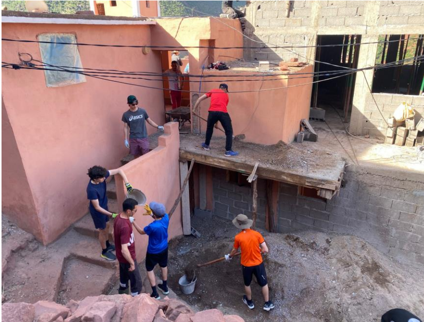
Construction de classes- bibliothèque dans l'Ourika, 2026
